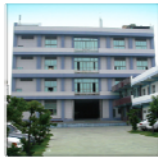
彰化廠 面積: 7,117m 2 生產線: 13 員工數: 208
